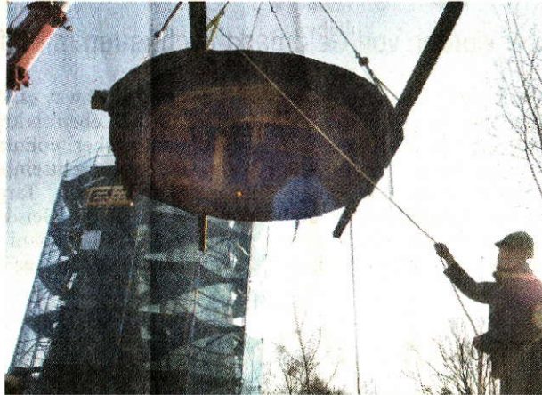
Im Februar 2009 wurde die Kappe demontiert. Foto: Volker Herold
